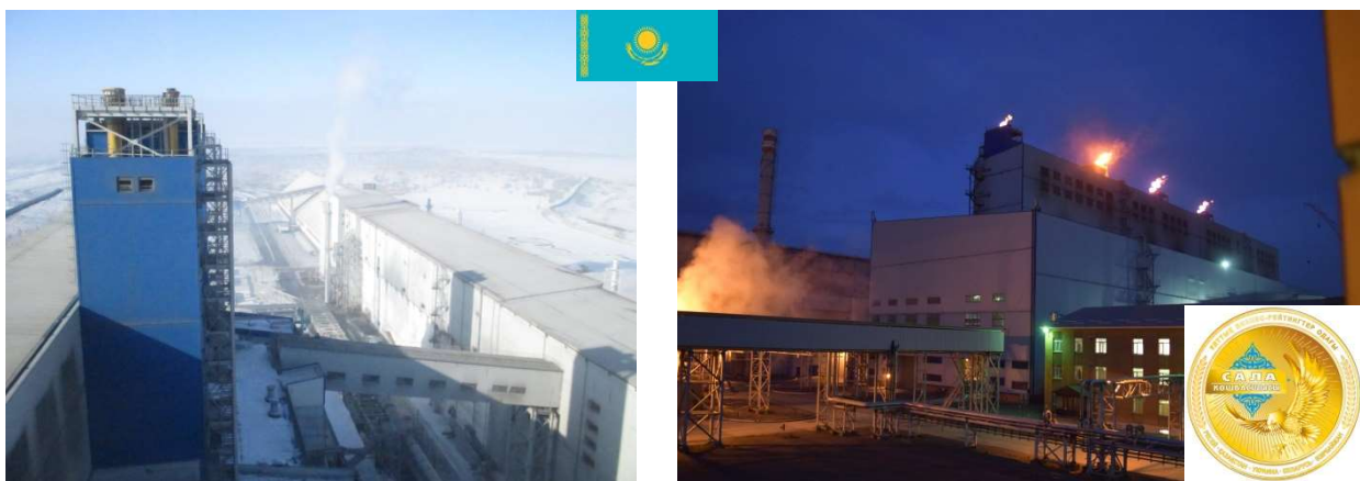
GCPs for 4 off fully enclosed FeCr DC-Smelting in Aktobe (Kazakhstan)
