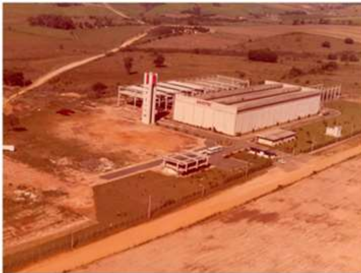
1983: Construcción de la fábrica
